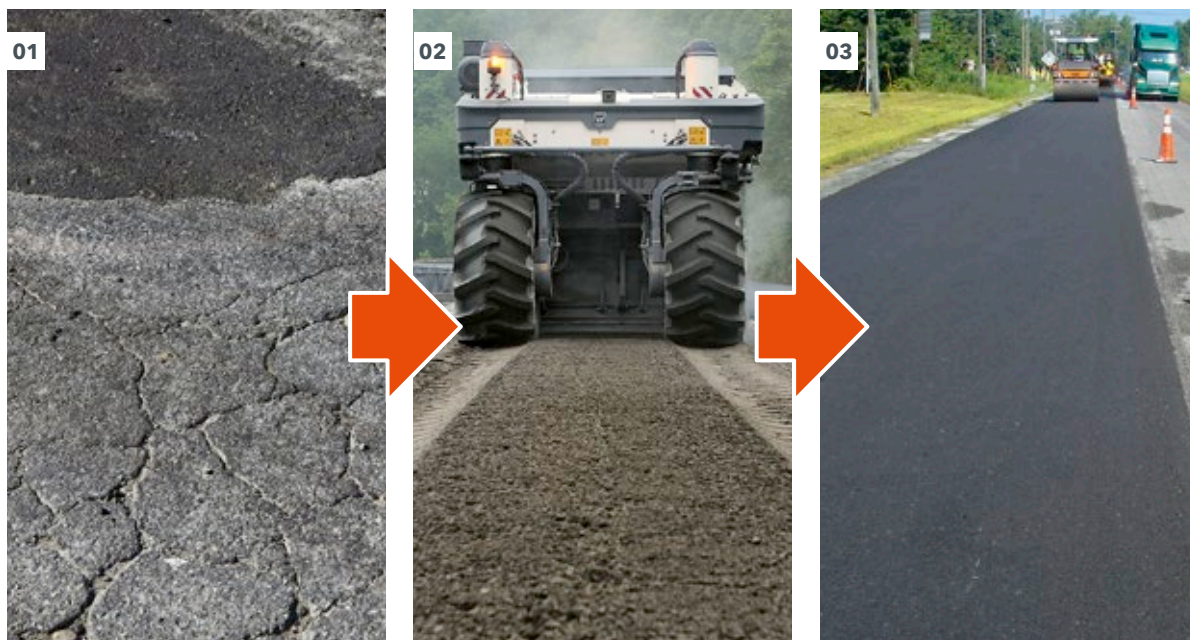
01 - 04 Nel riciclaggio a freddo, gli strati di asfalto ammalorati vengono granulati, miscelati con il legante, trattati, compattati e stesi nuovamente.
