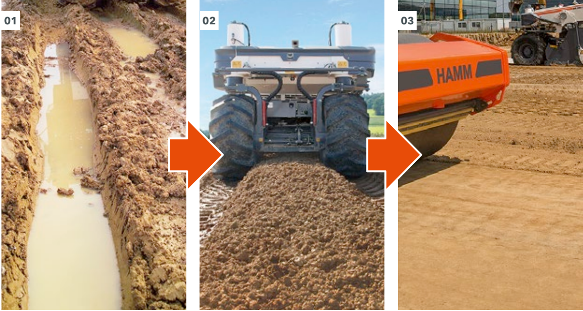
01 - 04 Nella stabilizzazione delle terre, il sottofondo non sufficientemente portante viene trasformato in una terra ben stendibile e compattabile.
