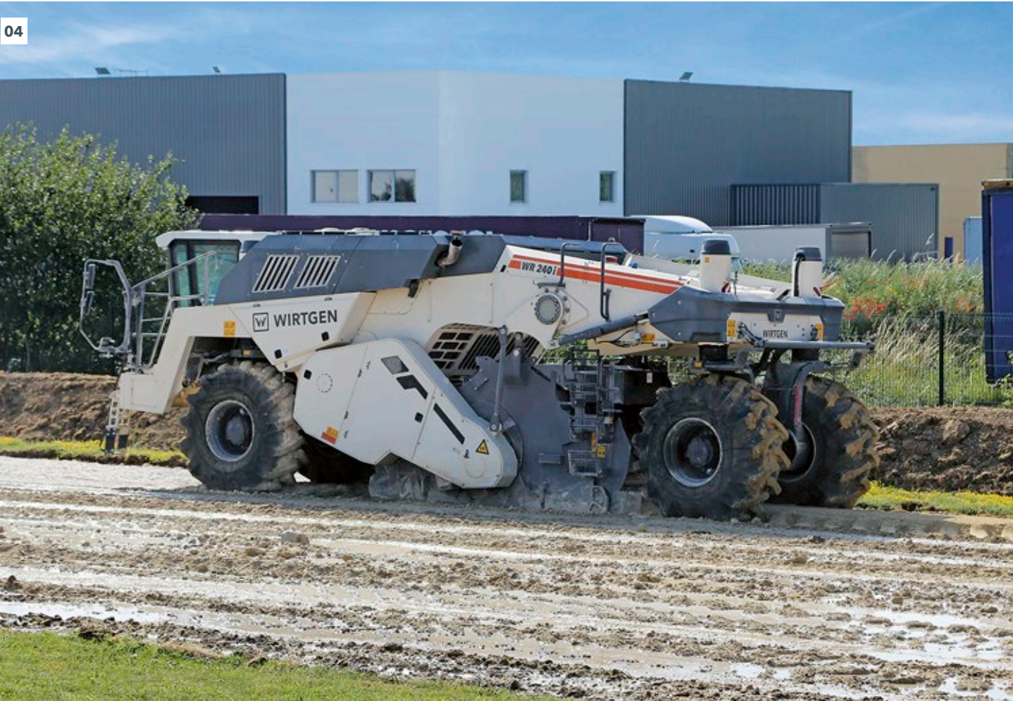
01 - 04 Nella stabilizzazione delle terre, il sottofondo non sufficientemente portante viene trasformato in una terra ben stendibile e compattabile.
