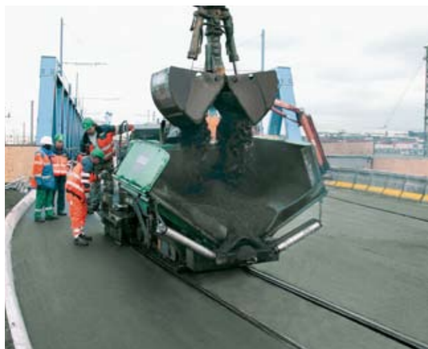
Stesa di conglomerato bituminoso tra rotaie tranviarie
