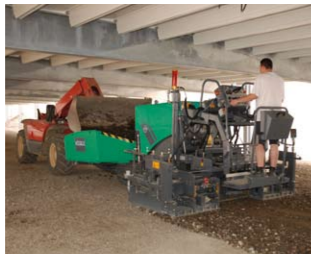
Interventi all'interno di edifici
