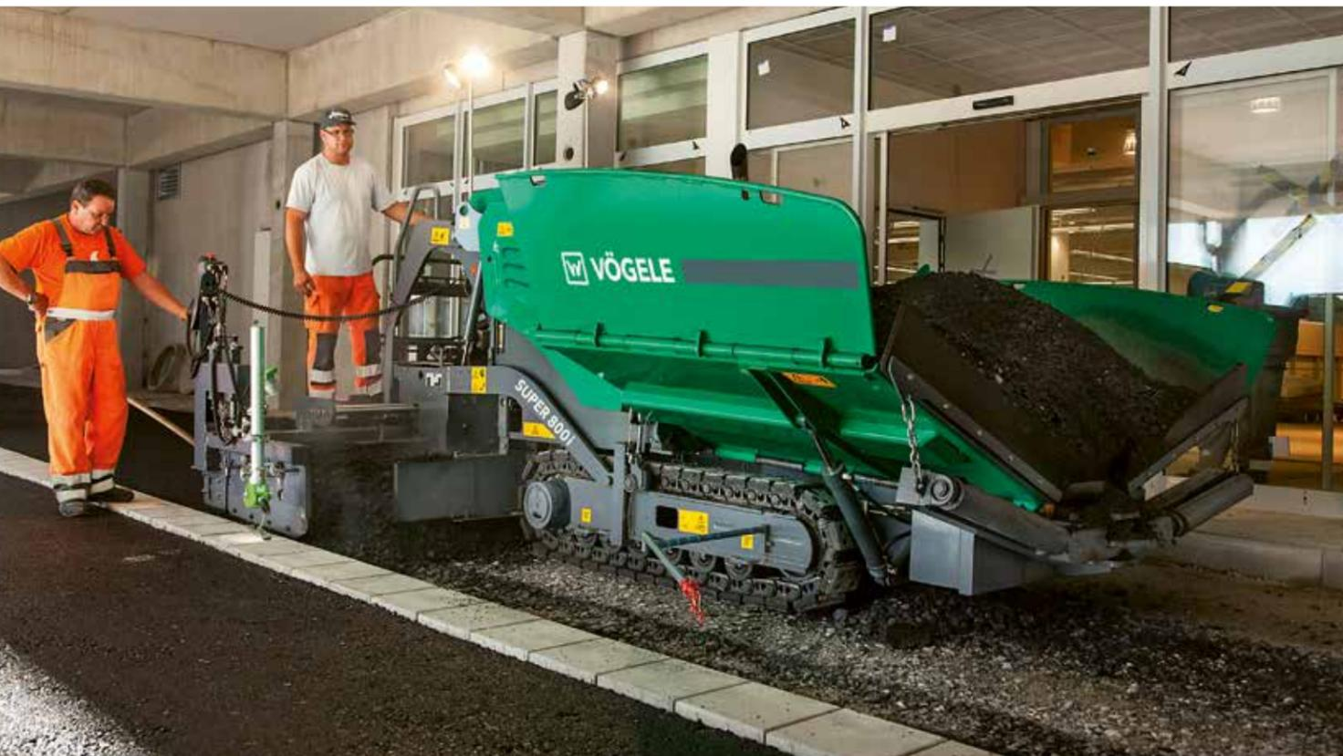
刮板输料器为后部驱动,其优势在于:优化的强劲驱动,确保了供料能力大、磨损低。刮板输料器可以小范围反转,因此,变换工地时不会撒料。
