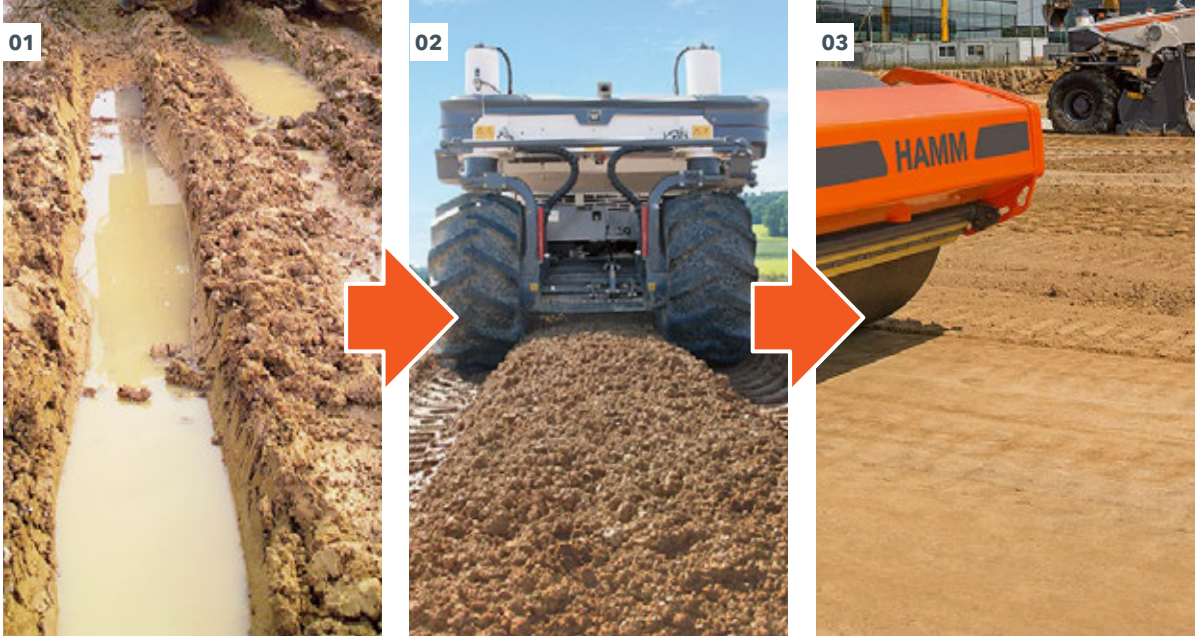
01 - 04 Os estabilizadores de solo transformam sub-bases com resistência deficiente em solos passíveis de pavimentação e compactação.
