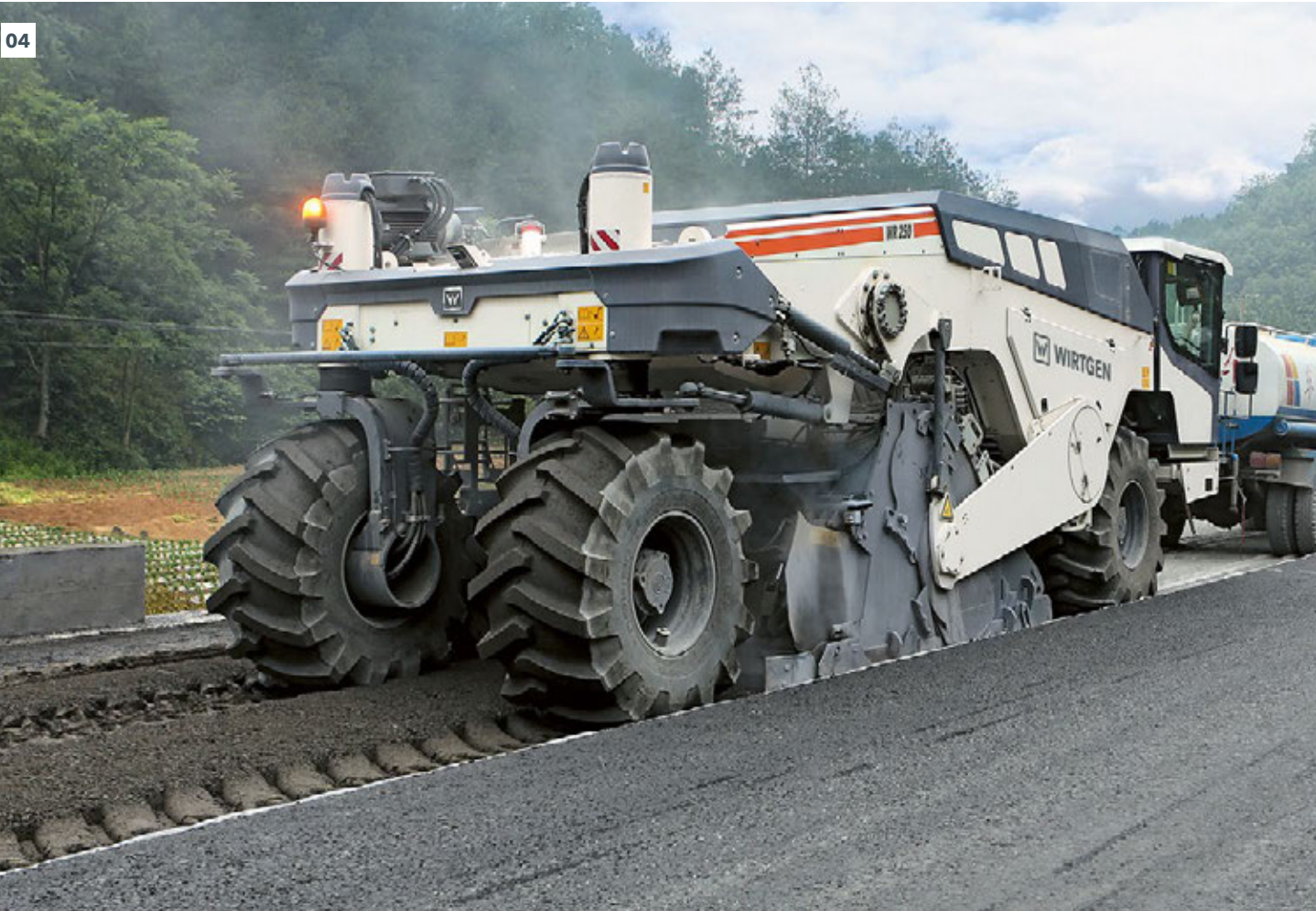
01 - 04 Na reciclagem a frio, as camadas de asfalto danificadas são granuladas, misturadas com ligantes, tratadas, compactadas e aplicadas novamente.
