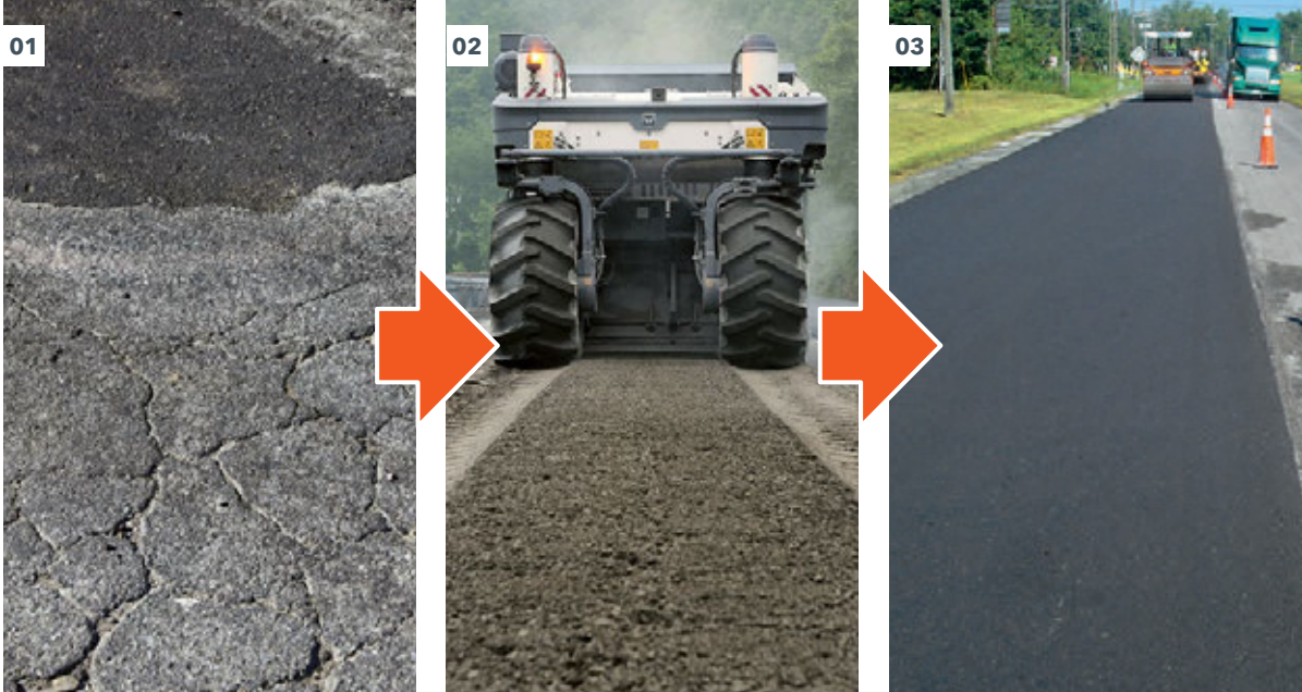
01 - 04 Na reciclagem a frio, as camadas de asfalto danificadas são granuladas, misturadas com ligantes, tratadas, compactadas e aplicadas novamente.
