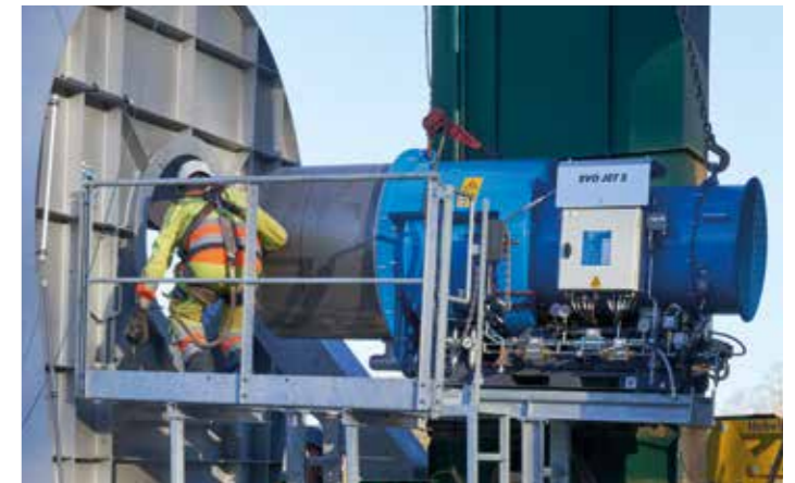
Retrofit katı yakıtlı brülörün (ahşap)
