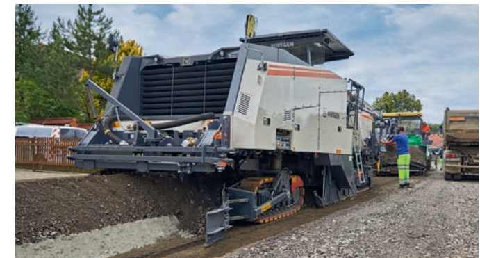
W 240 CRi รีไซเคิลทั่วทั้งความกว้างของช่องทางรวมทั้งการกวดไสและปูผิวทาง
